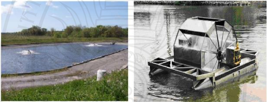
ภาพที่ 8.13 ระบบบ่อบอกซิเดชัน(ซ้าย) และระบบเติมอากาศด้วยกังหันน้ำชัยพัฒนา(ขวา) (ที่มา : มูลนิธิชัยพัฒนา, 2557)
